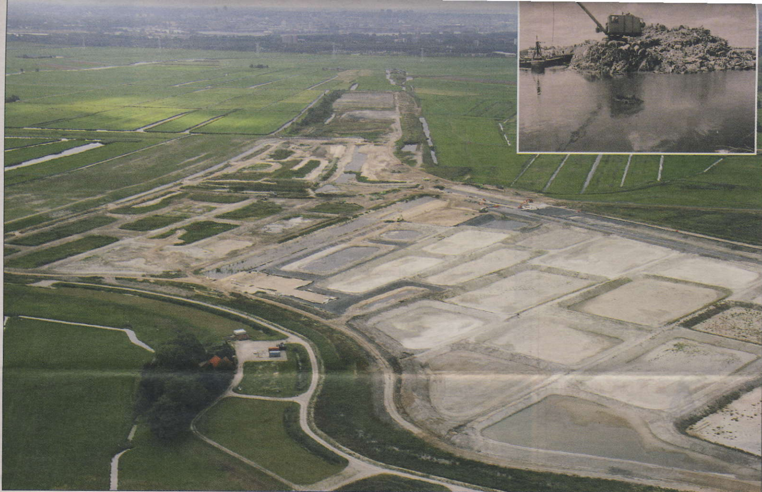
De aanleg van de natuurlijke kap in de Volgermeer. Inzet: De vondst van de gifvaten in 1980 zorgde voor één van Nederlands grootste milieuschandalen
